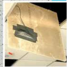
Infinidad de cámaras ocultas en el plafón de las oficinas
